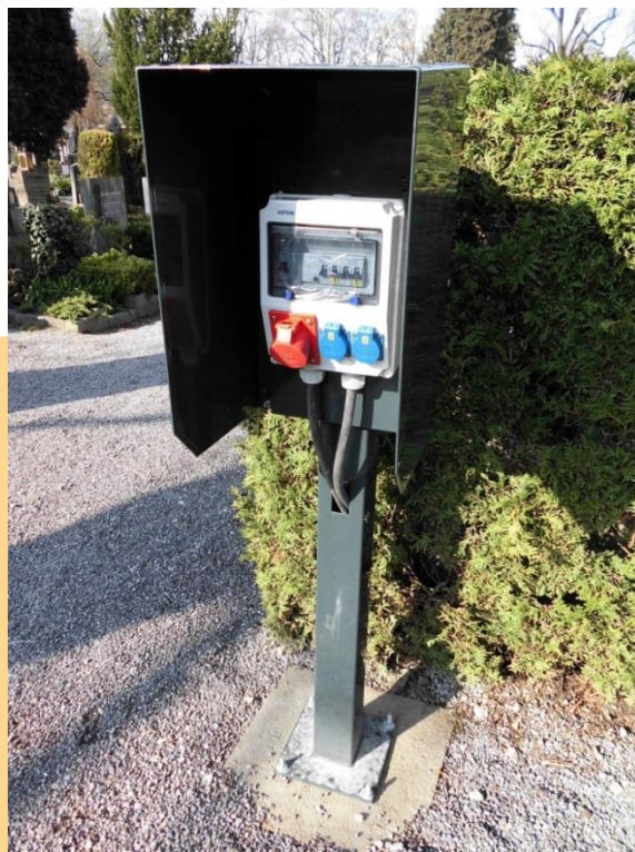
Verlegung einer Elektroversorgung am südlichen Teil des Westfriedhofes
